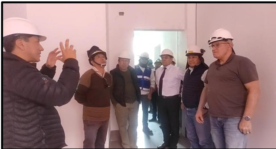
Inspección de los ambientes en construcción del Hospital de Cotaruse junto con autoridades y personal técnico.
