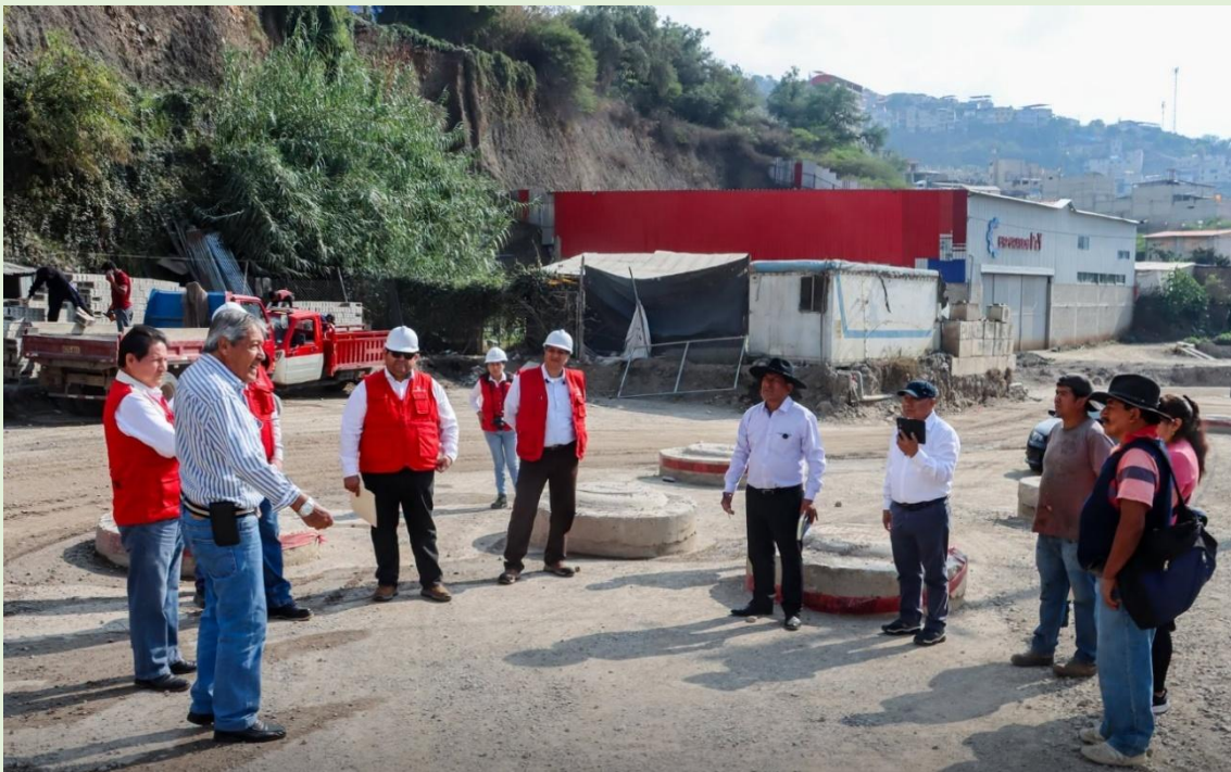
Visita a la obra de construcción de la vía de evitamiento de la ciudad de Abancay.
